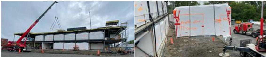
Figure 3.4: Levage et positionnement des chambres modulaires
