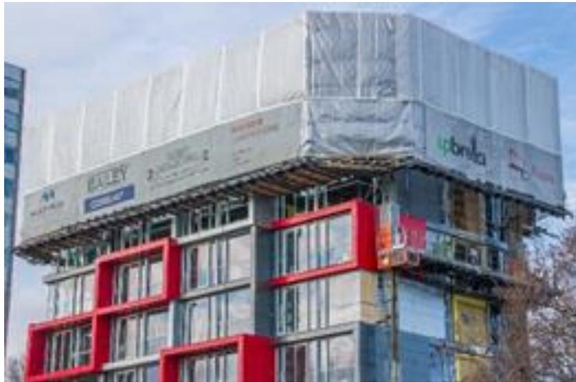
*Figure 3.5: Système de construction abritée en hauteur*
