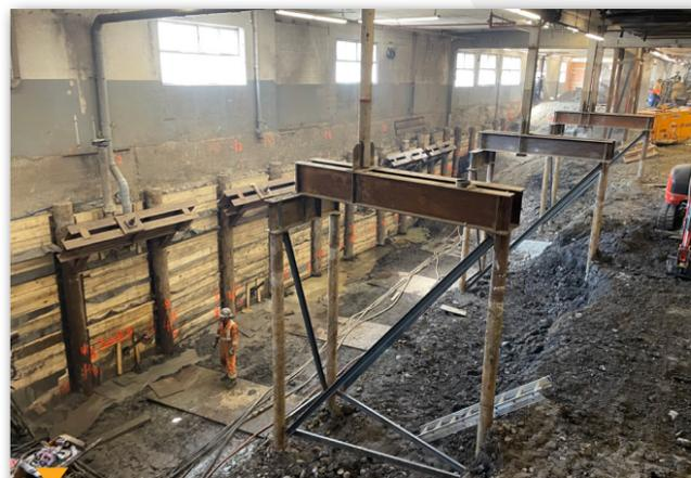
Excavation avec mesures de soutènement latéral et vertical sous un bâtiment de trois étages en béton. Un concept novateur de soutènement en tripode fut développé (envergure 3 000 000\$)
