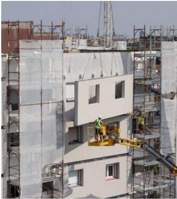
Rénovation profonde du complexe Via Russoli, Milan
